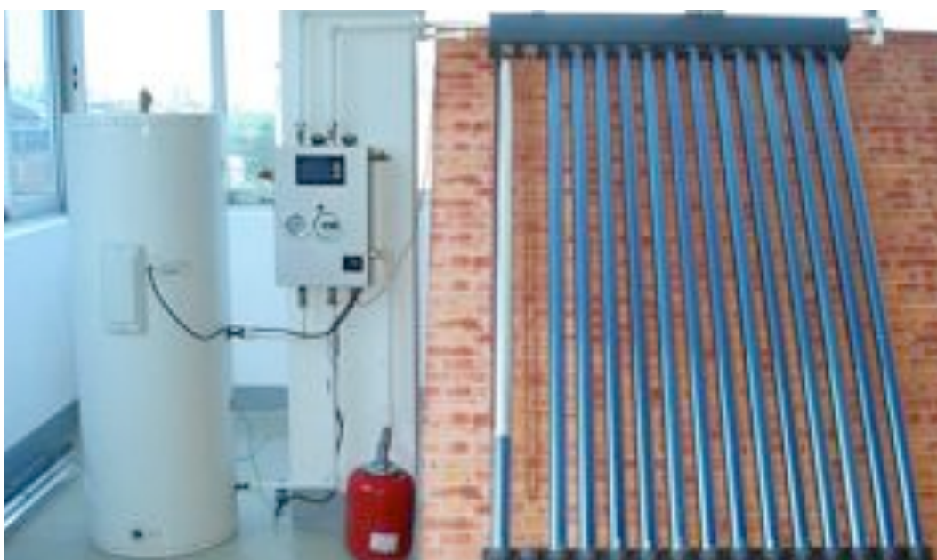
zonneboiler voor warmtapwater
