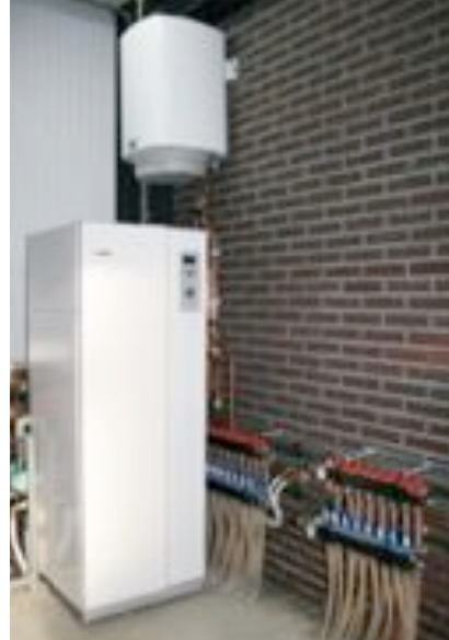
warmtepomp met bron
