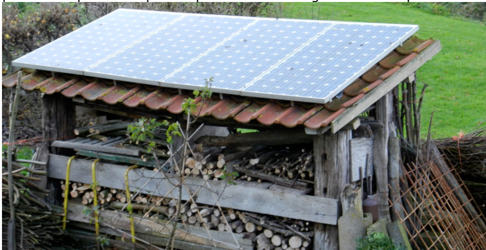
pv-cellen voor het opwekken van elektriciteit
