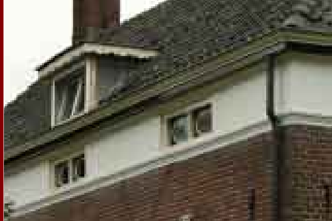
rechthoekig venster direct onder daklijst
