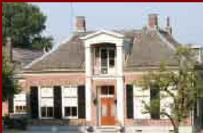
voorhuis leipannen dak
