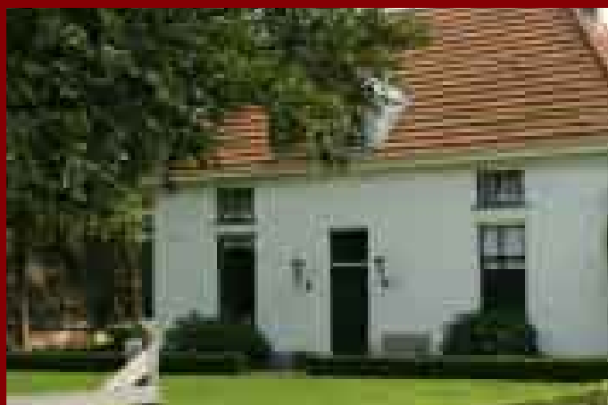
gevel wit gestuukt en pannendak
