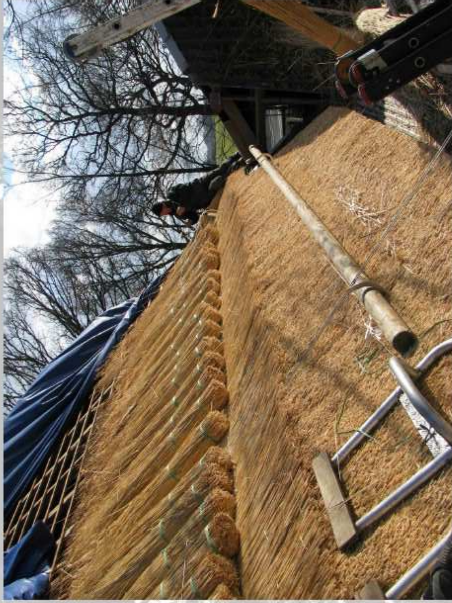
De traditionele wijze met rietlatten
