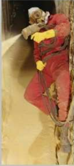
PUR schuim aanbrenge
