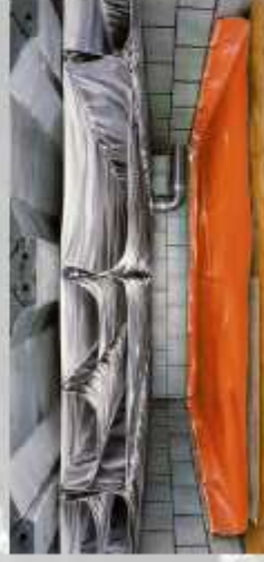
Luchtdichte zakken aanbrengen
