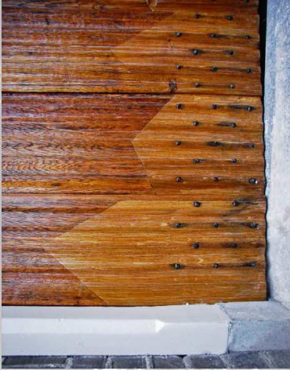
Aanscherpen van een deur
