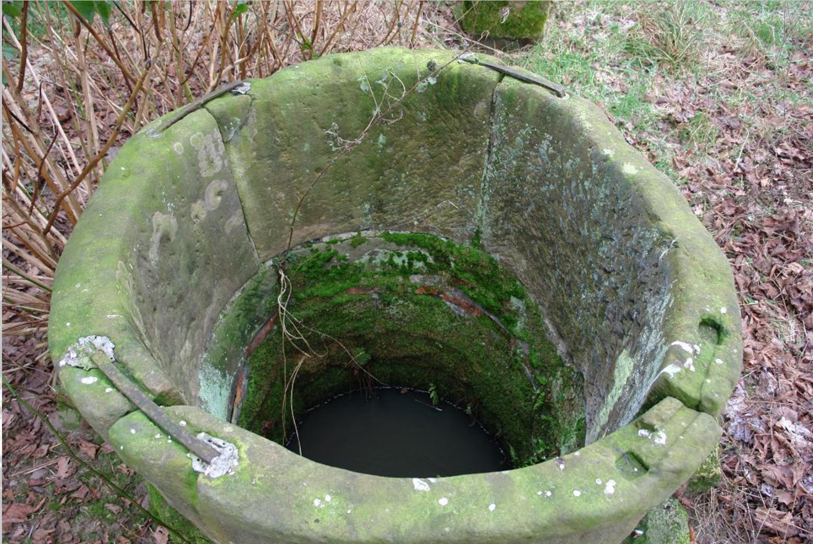
Waterput met klemstrippen in lood gegoten
