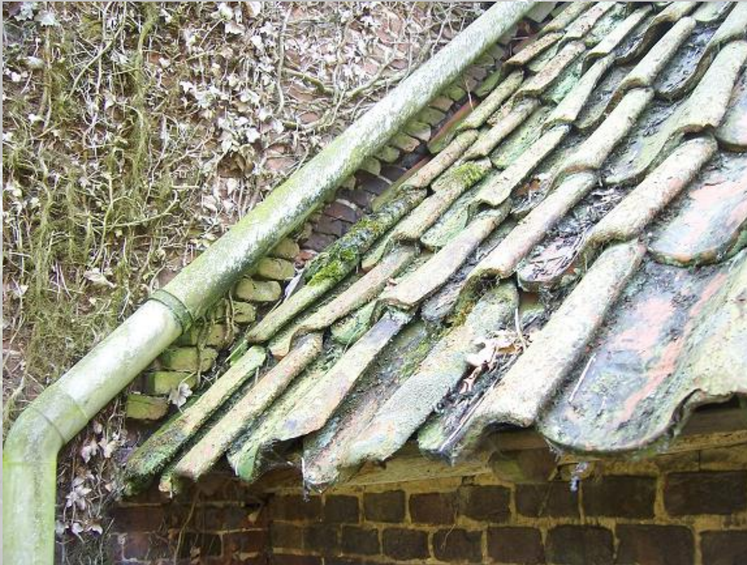
Waterkering door middel van een vallende bloktand
