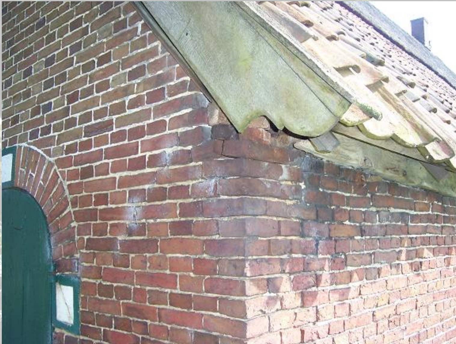
Windveren met opschalking
