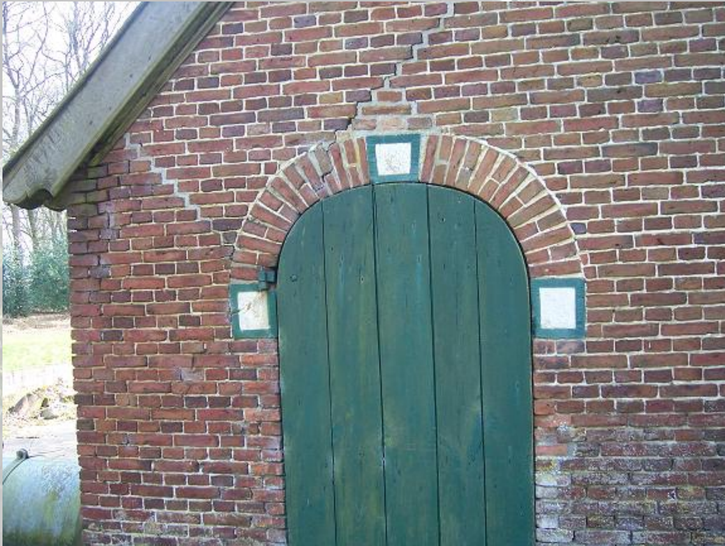
Opgeklampte staldeur en scheuren in het metselwerk
