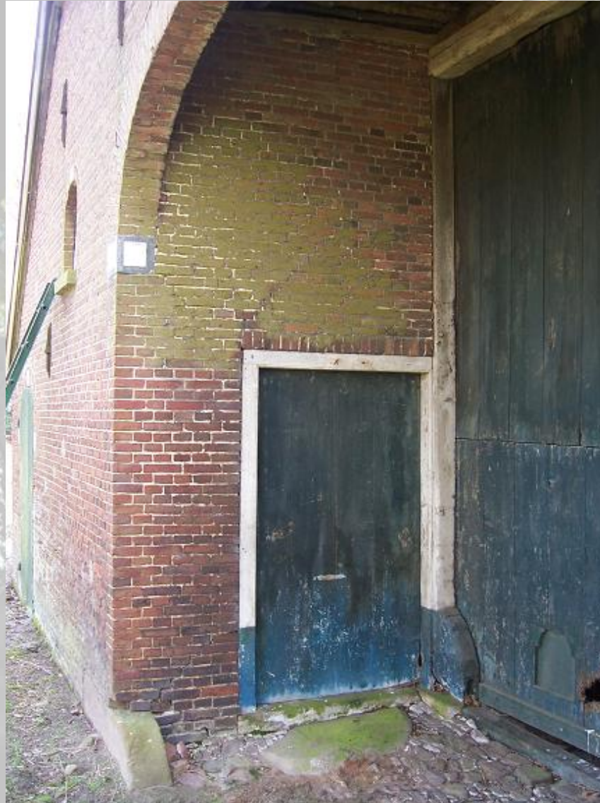
Loopdeur naast de niendeur in het onderschoer
