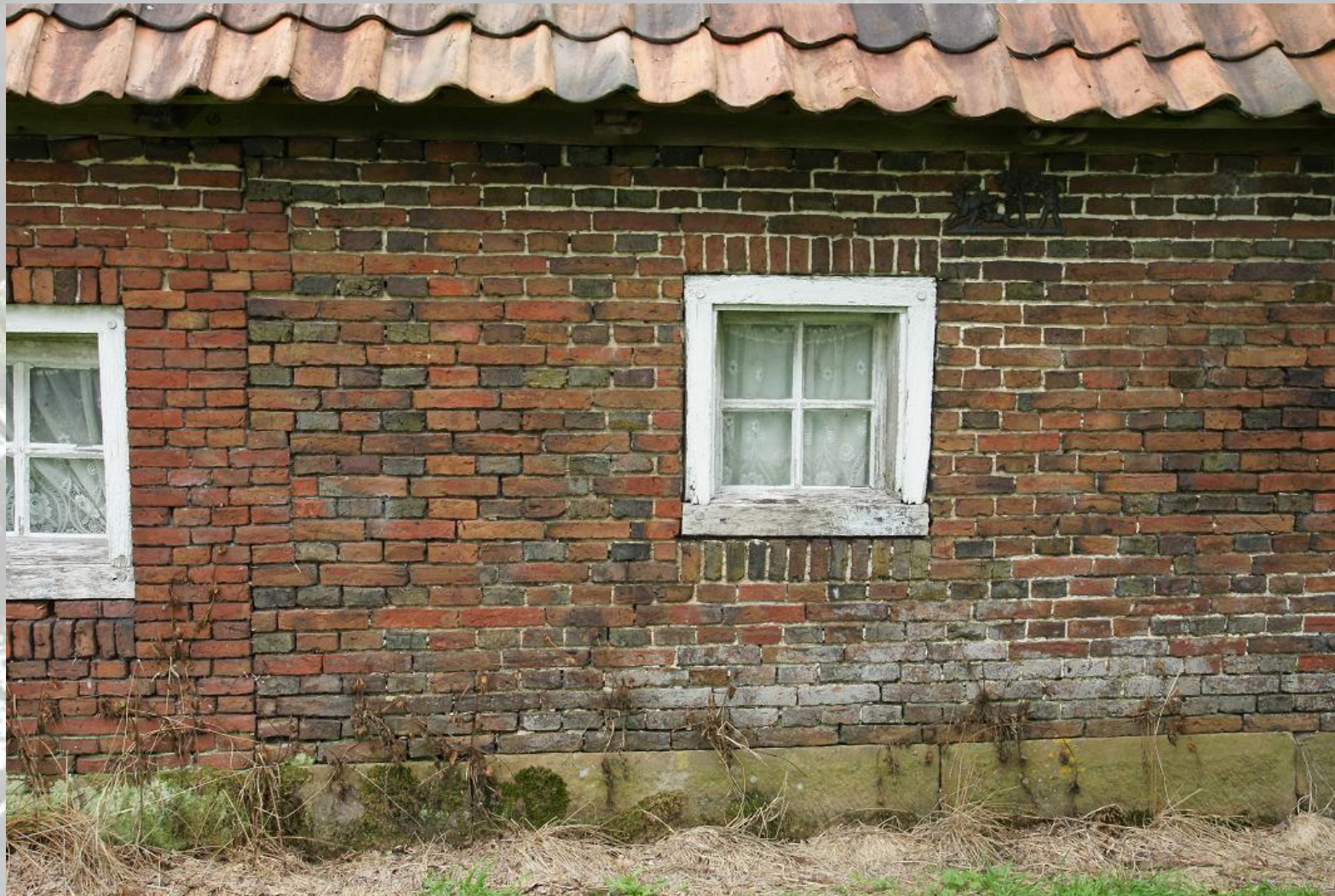
Bentheimer zandsteen plint en bouwspoor in metselwerk
