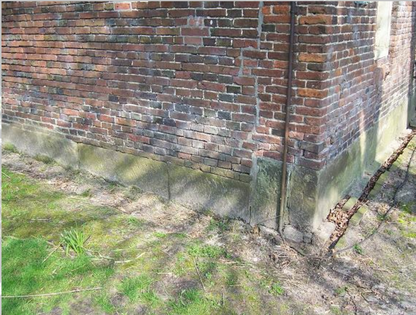
Inkassing in het metselwerk
