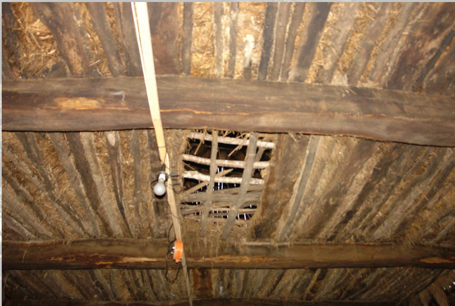
Ventilatieopening in de slietenzolder
