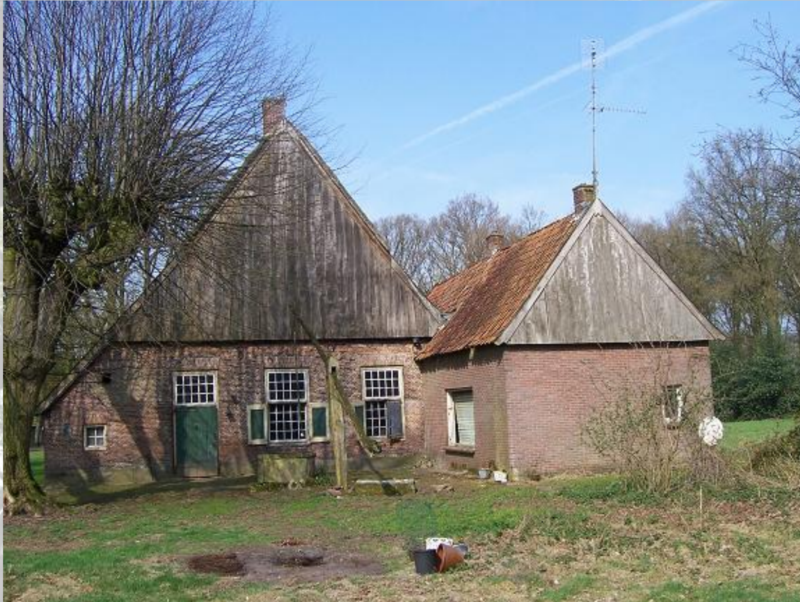
Houten topgevels van eiken en een fijne roedenverdeling
