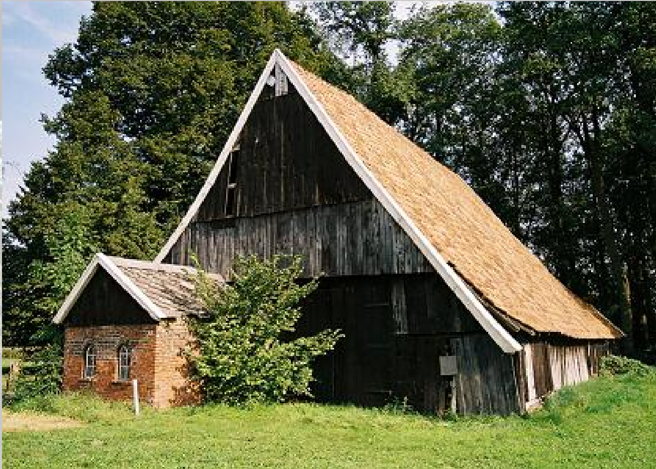
Restauratie/Renovatie schoppe bij Scholtengoed Boeijink
