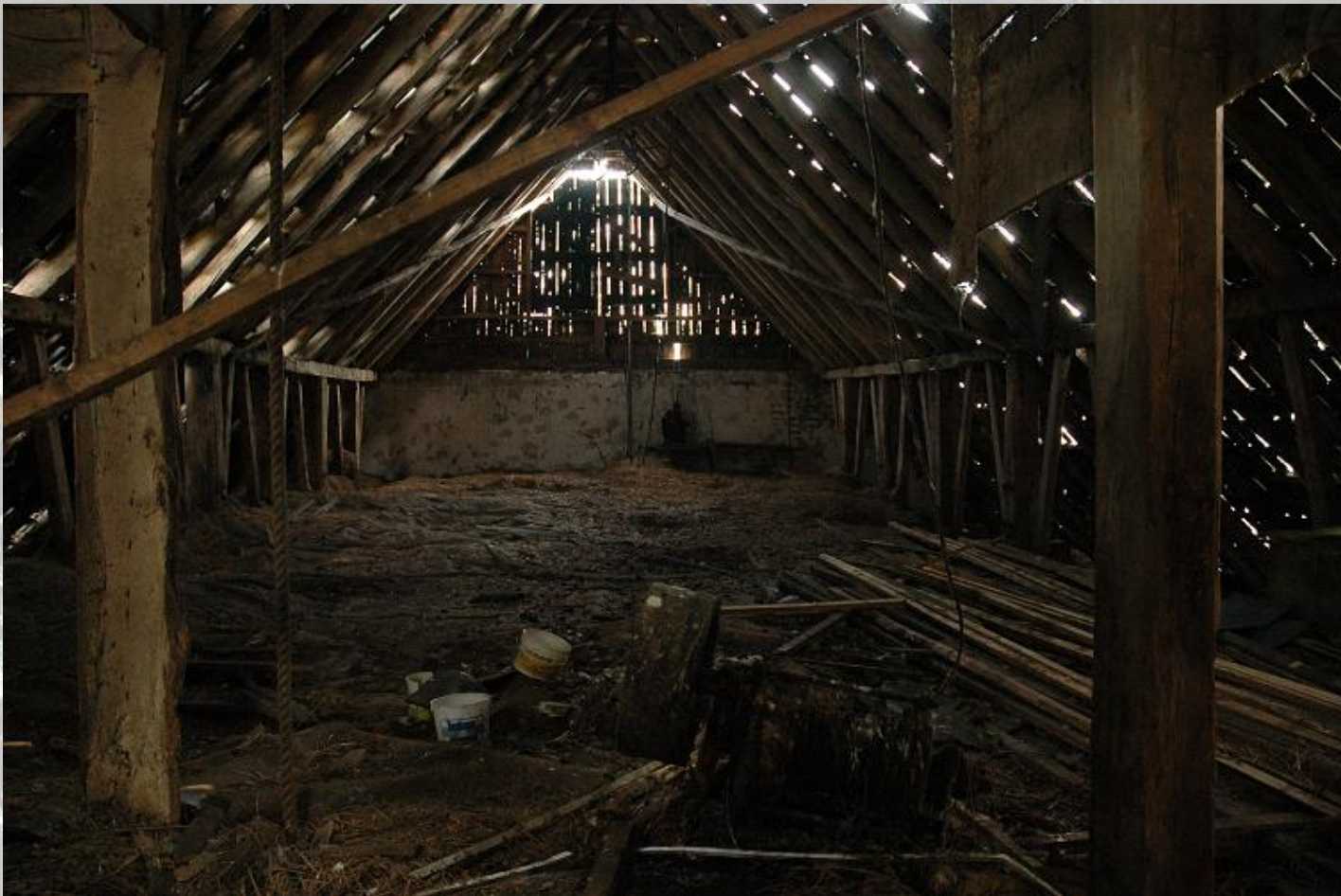
De enorme hooizolder
