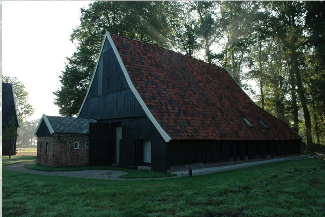
De Schoppe voor, tijdens en na de renovatie
