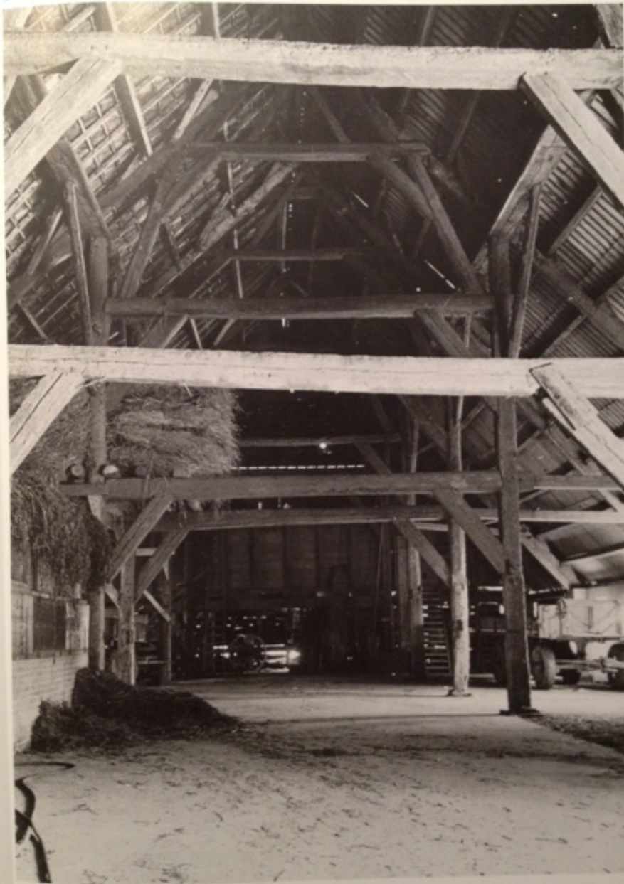
Foto 11. Stangensysteem met dubbele ankerhalkgebinten in de sluis van de sluis van de Sluis van Sluisburg, Sluisse Dijk 24 de Zeesluis (Z.A. 1950)
