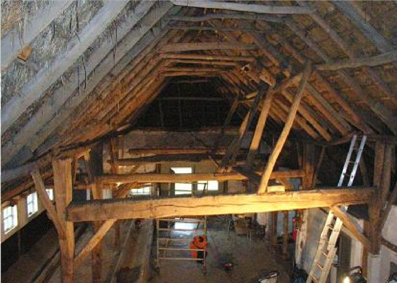
Aanblik na het verwijderen van de slieten
