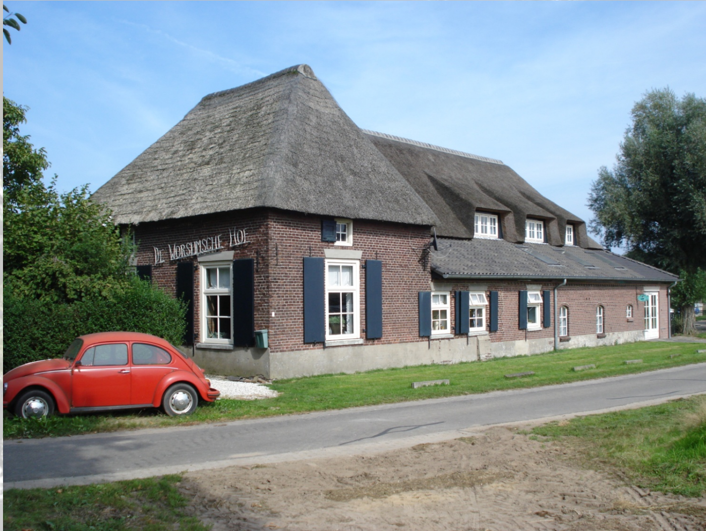
De rieten dakbedekking
