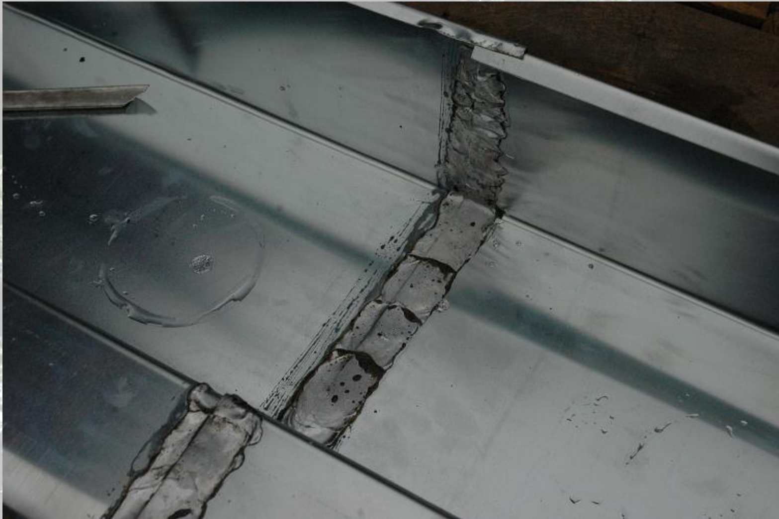
Het eindresultaat, een waterdichte verbinding
