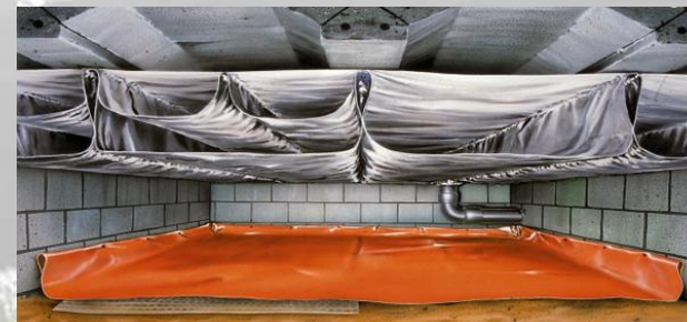
Luchtdichte zakken aanbrengen
