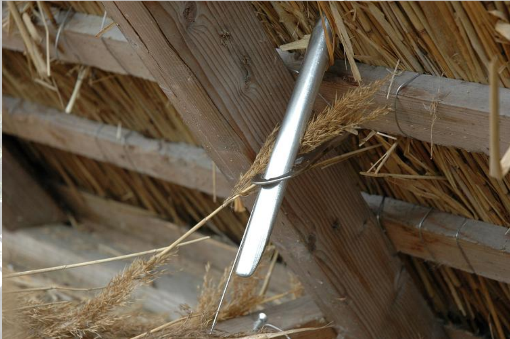
De bovenste pin is hol en voorzien van binddraad, de onderste heeft een oog
