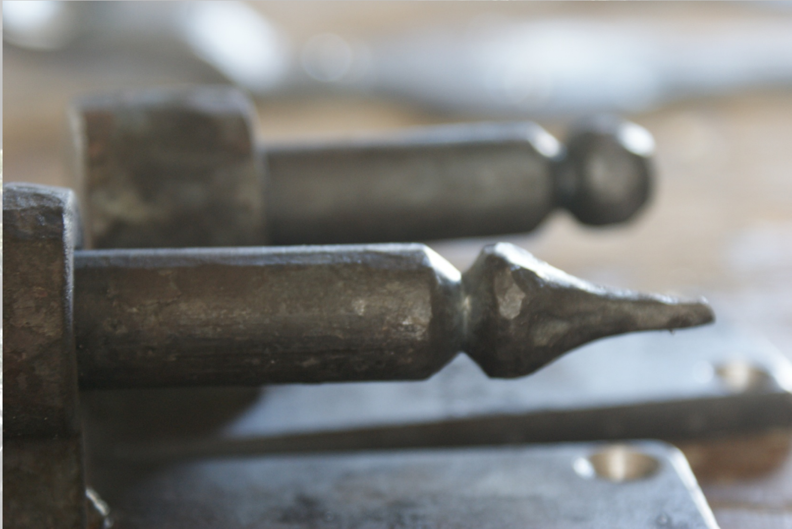
duimkoppen met een peer en een appel beëindiging (peer boven)
