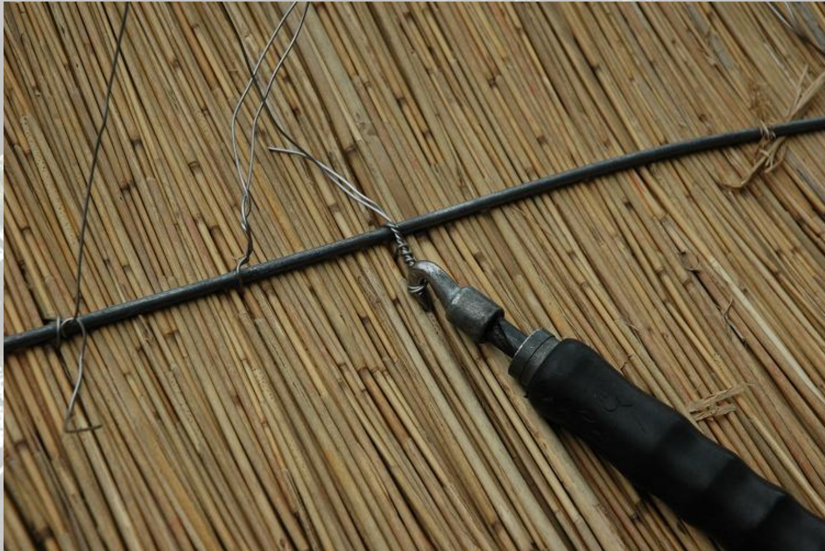
Een schroevendraaier om de binddraden om de roede te draaien
