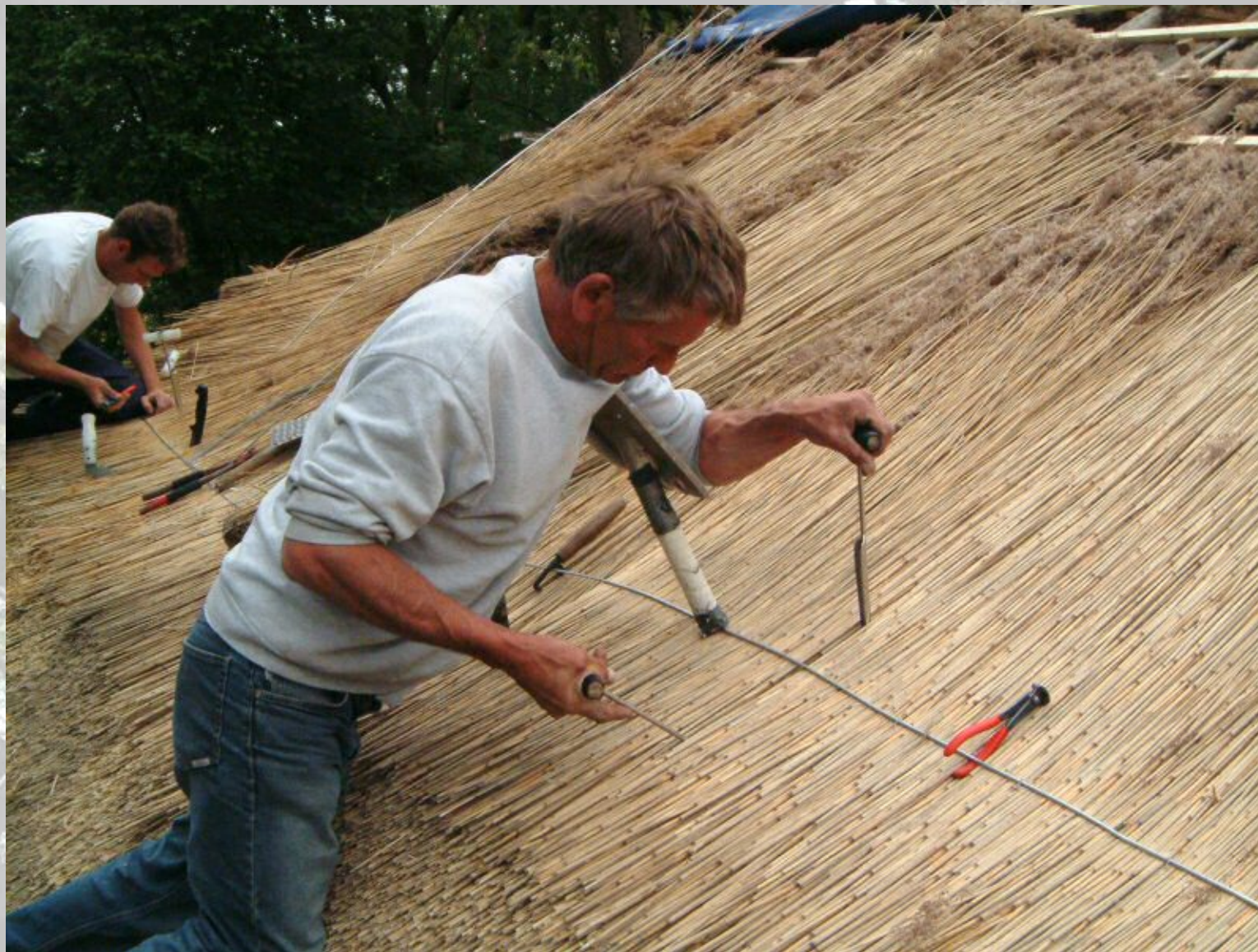
Het systeem om de binddraad "blind" om de rietlat te vouwen
