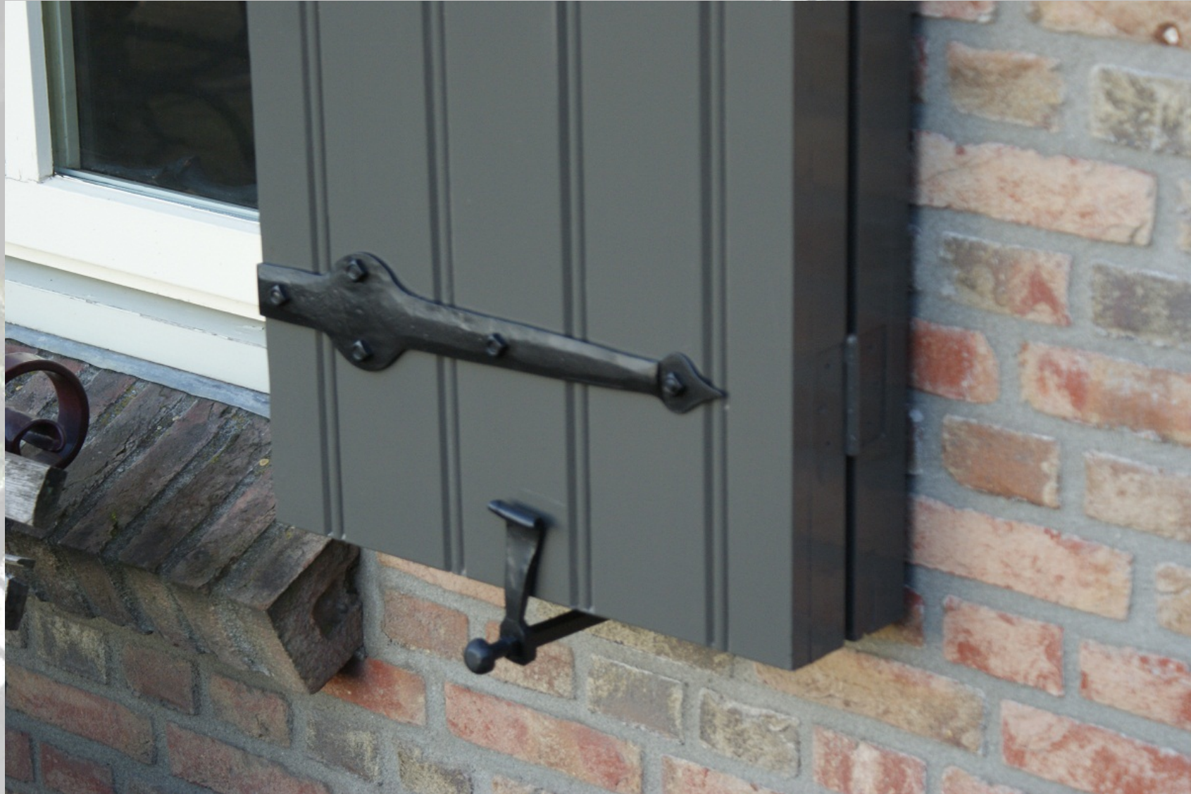
Dubbelslags luiken met gehengen en wervels
