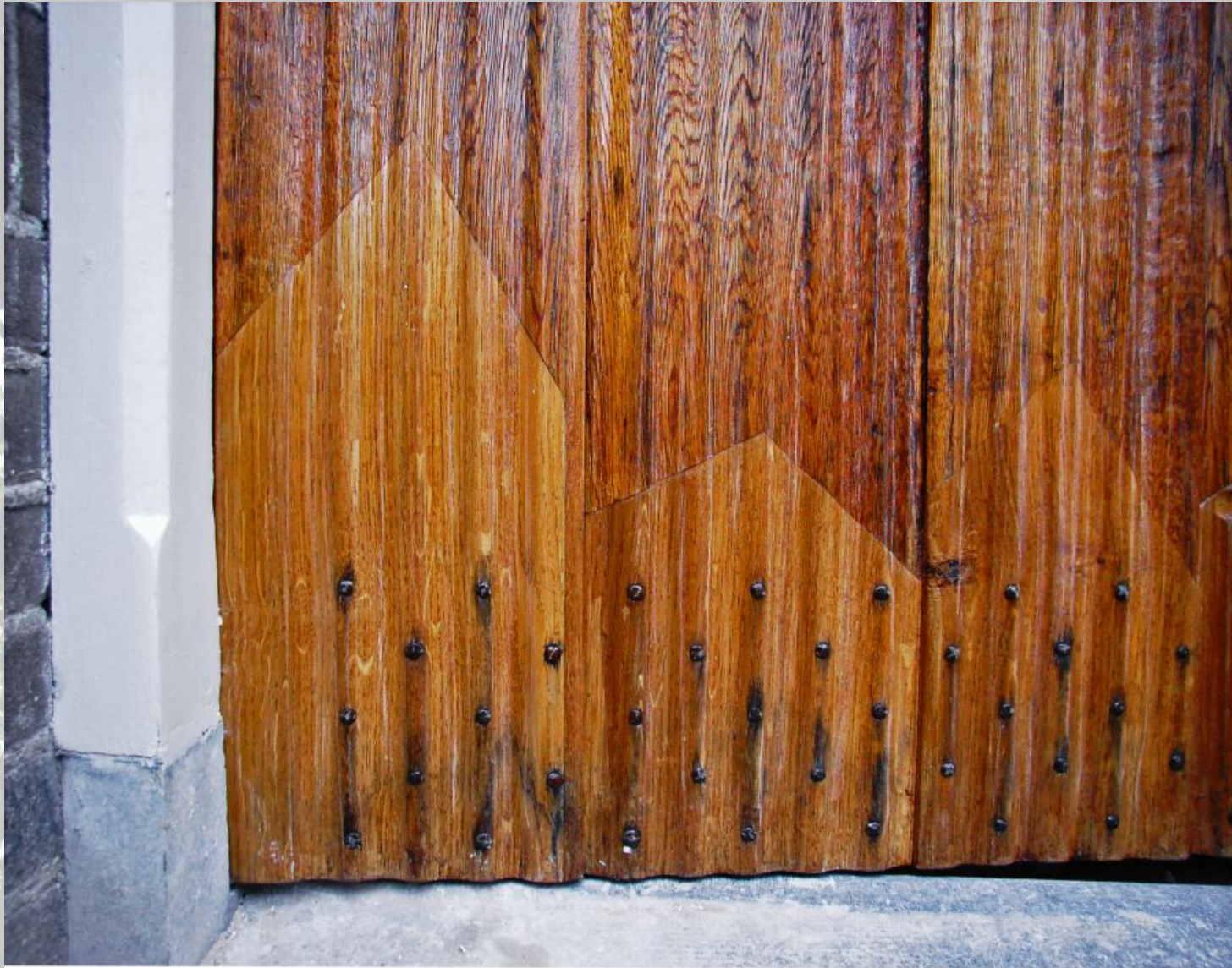
Aanscherven van een deur
