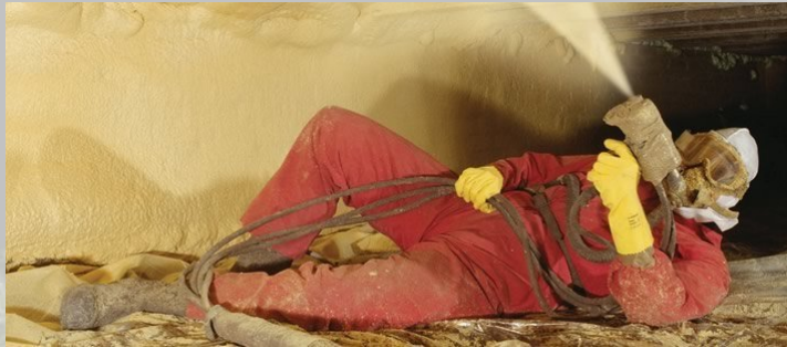
PUR schuim aanbrengen
