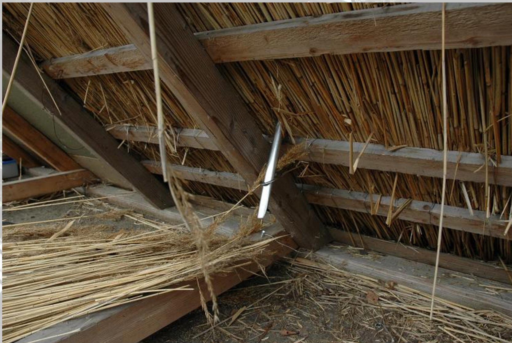
De meest gehanteerde methode met dubbele pin
