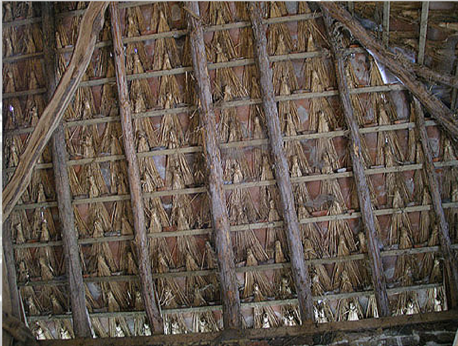
Strodokken werden aangebracht onder de pannen
