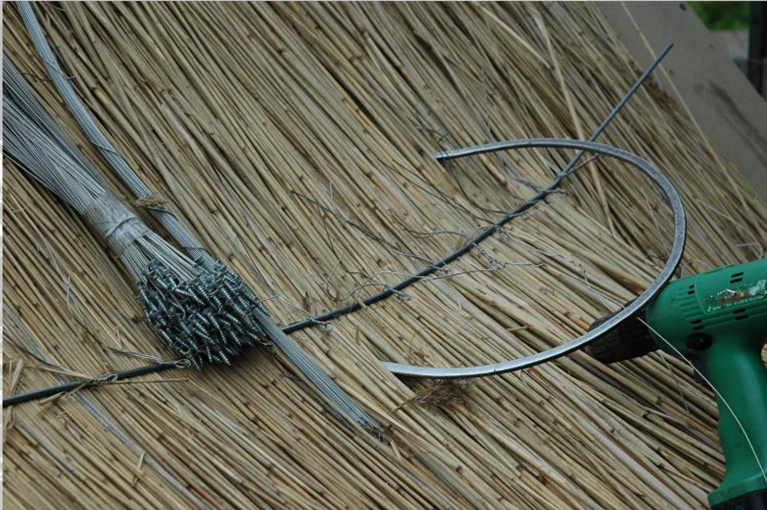
Het riet vastzetten met schroef en draad, en met een sikkel
