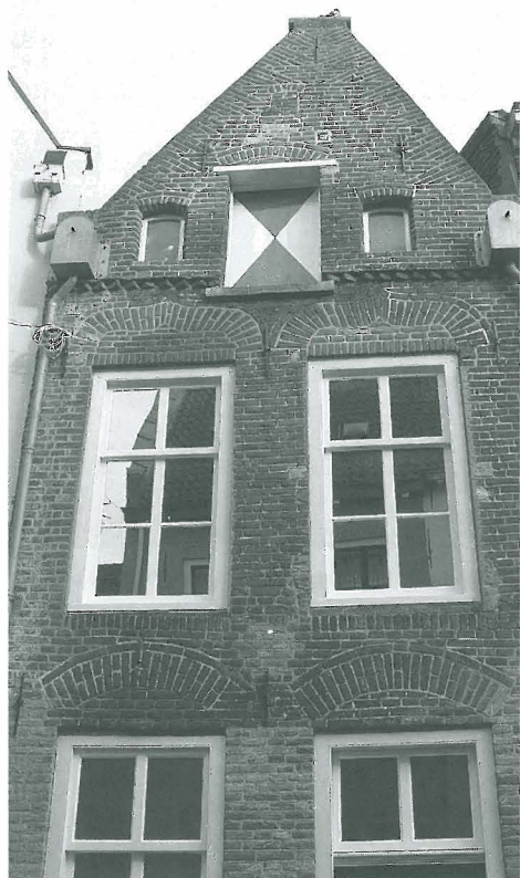
Een opmerkelijke gevel in de Vaalstraat
