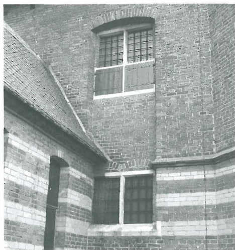
St. Walburgis. Onder bolvenster, boven kruisvenster
