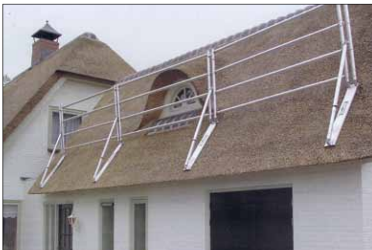
Afbeelding 16 Een goedgekeurde valbeveiliging die speciaal ontwikkeld is voor rieten daken.
