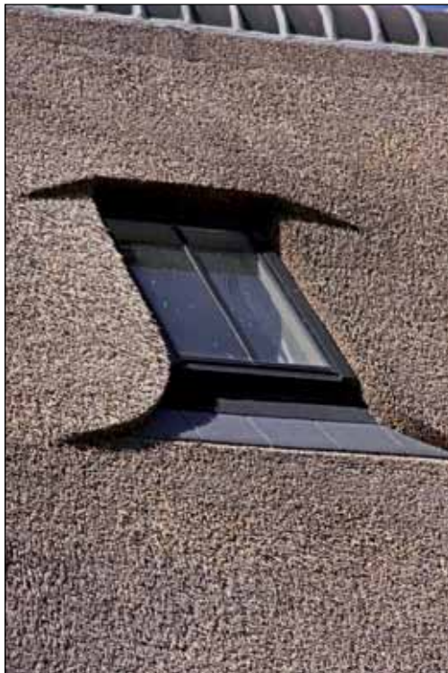
Afbeelding 32 Een modern ingedekt dakvensters. Door de zwarte coating en de middenstijl valt het venster minder op.
