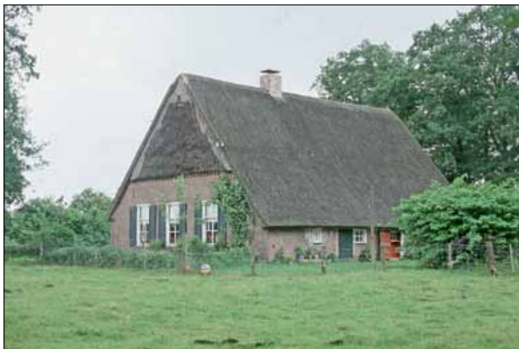
Afbeelding 10 Heide gebruikt als afsluiting van een zeer steile topgevel van een boerderij te Schoonebeek.
