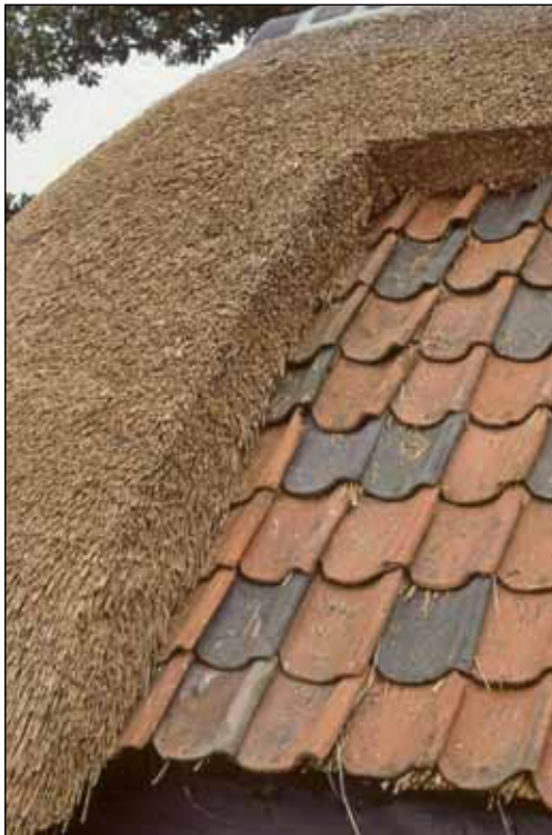
Afbeelding 38 Bij de aansluiting van het riet op de dakpannen, het riet voldoende doorzetten over de pannen.
