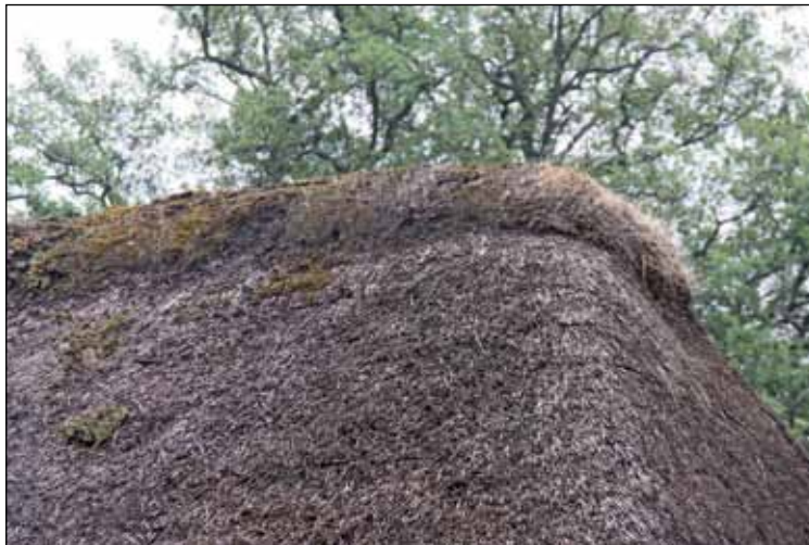
Afbeelding 28 Een vorst met plaggen in het Openluchtmuseum van Bokrijk in België. De vorst raakt begroeid en vergt regelmatig onderhoud.
