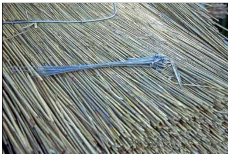
Afbeelding 13 Een bosje roestvaststalen draden in het midden gewarteld om een roestvaststalen schroef voor het binden op een schroefdak.
