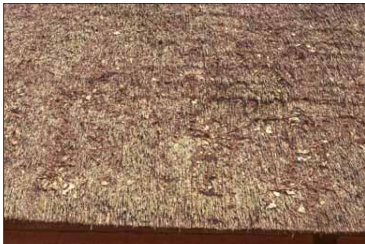
Afbeelding 49 De slijtlaag is zover verteerd, dat de gaarden er door heen schemeren. Afhankelijk van de conditie van het riet zelf kan bepaald worden of blank verstoppen nog zinvol is.
