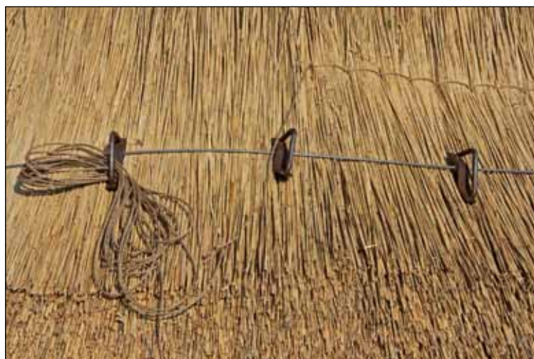
Afbeelding 27 De binnenzijde van een achtkant van een molen. Duidelijk is touw te zien waarmee het riet is genaaid. De afstand van de binding is circa 17 cm.
