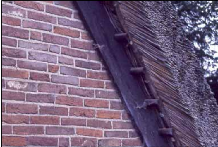
Afbeelding 14 Een voorbeeld van een breeuw met een knelplank bij een opgaande gevel van een boerderijtje. Duidelijk is het uitwaaiëren van het schuin gelegde riet te zien.
