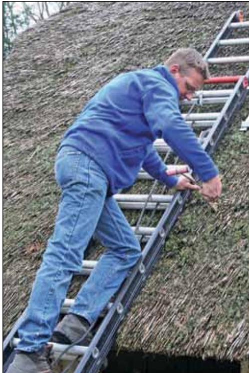
Afbeelding 47 Het meten van de dikte van het rietdek en de slijtlaag. Ook worden stengels er uitgetrokken voor beoordeling van de kwaliteit van het riet.
