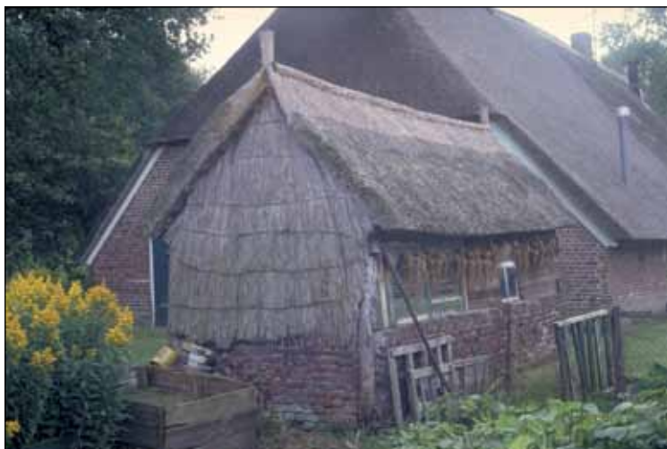
Afbeelding 29 De levensduur van een overgebonden strovorst met rol en tuultjes is korter. Toch proberen deze streekgebonden karakteristiek zoveel mogelijk te handhaven.
