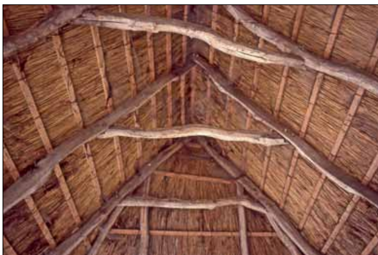
Afbeelding 11 Riet is verdraagzaam. Ook een authentiek sporenkapje van krom gegroeid eiken kan gehandhaafd worden bij een traditioneel gebonden rietbedekking.
