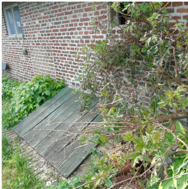
Van links naar rechts en van onder naar boven: gemetselde trap en bloembak uit de circa dertiger jaren van de twintigste eeuw, luik naar de kelder, erfverharding erf in gebruik als parkeerplaats, een notenboom met in de achtergrond de laanbeplanting langs de weg Zwolle-Wijhe.
