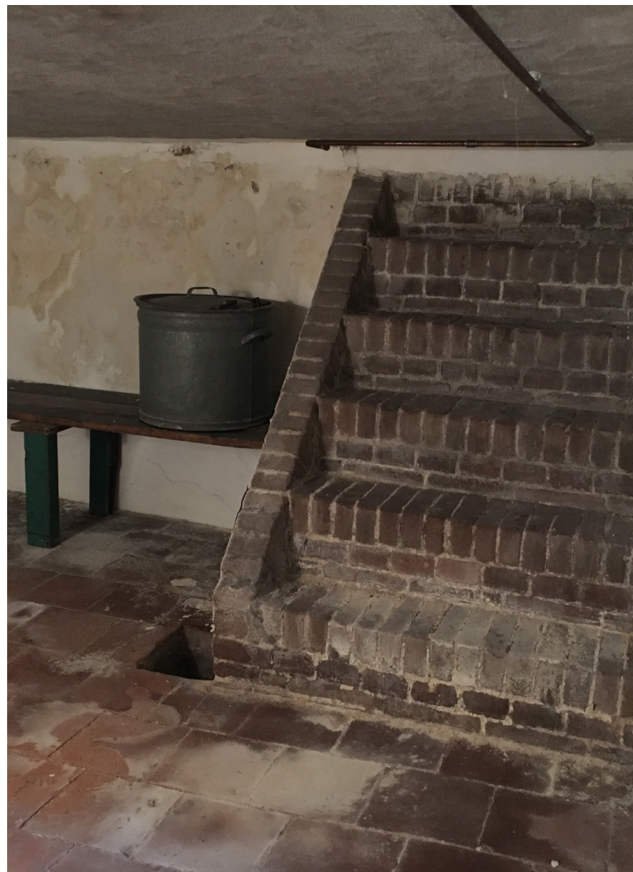
Afb. 7 Kelder met nieuw betondek, estrikken vloer en de gemetselde trap.
