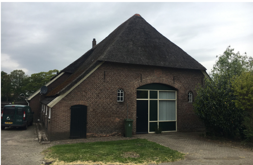
Afb. 10 De achtergevel van de boerderij.
