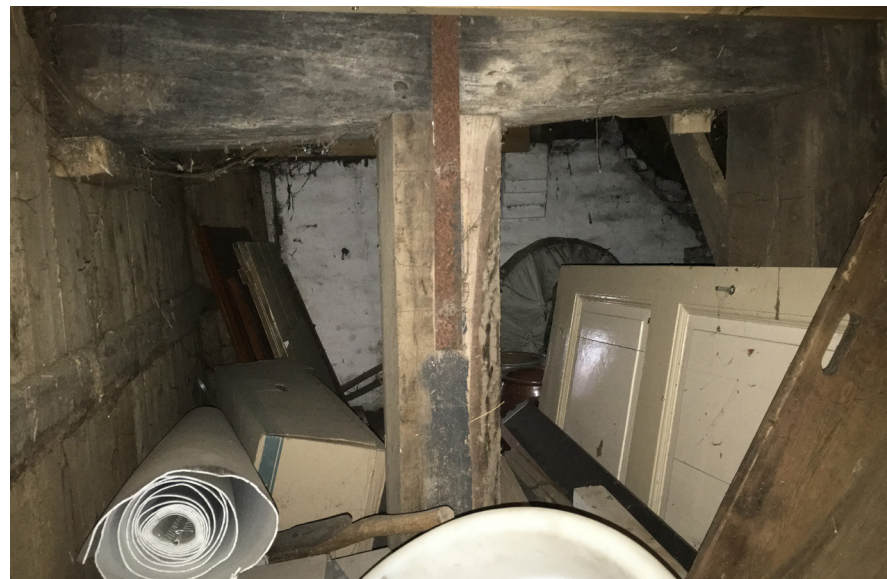
Afb. 9 De nieuwe stijl naast de oude (rechts), links het beschoot van de hilde, foto genomen op de hildebalklaag.
