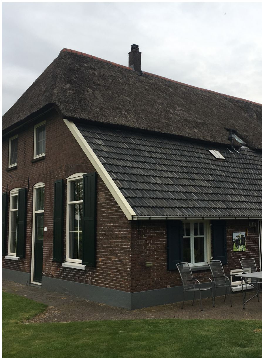
Afb. 6 Gedeelte van het voorhuis waar de opkamer zich bevond. De zij-dakvlakken zijn deels met riet gedekt en deels voorzien van blauwe vlakke muldenpannen.
