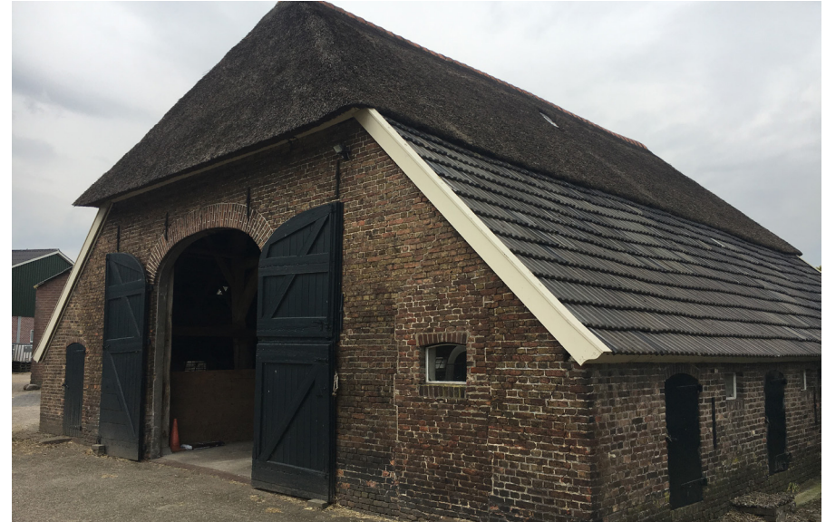
Afb. 14 Achtergevel van dezelfde schuur met de nog aanwezige niendeuren.
