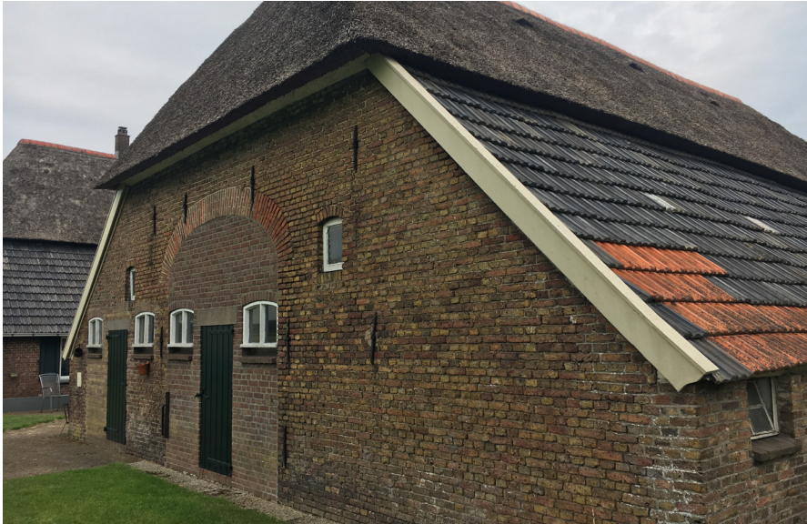
Afb. 13 De schuur die naast de boerderij staat is van het type doorrijshuur. In beide kopgevels zit namelijk een (bouwspoor van een) niendeur.
