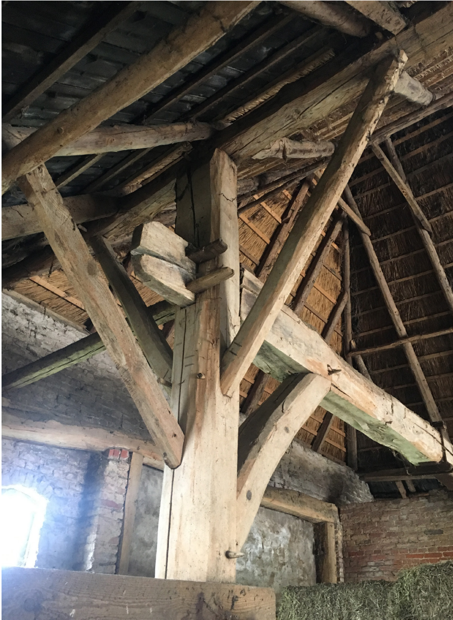
Afb. 19 De telmerken zijn zichtbaar op de staanders en de spreibanden (hier II).
