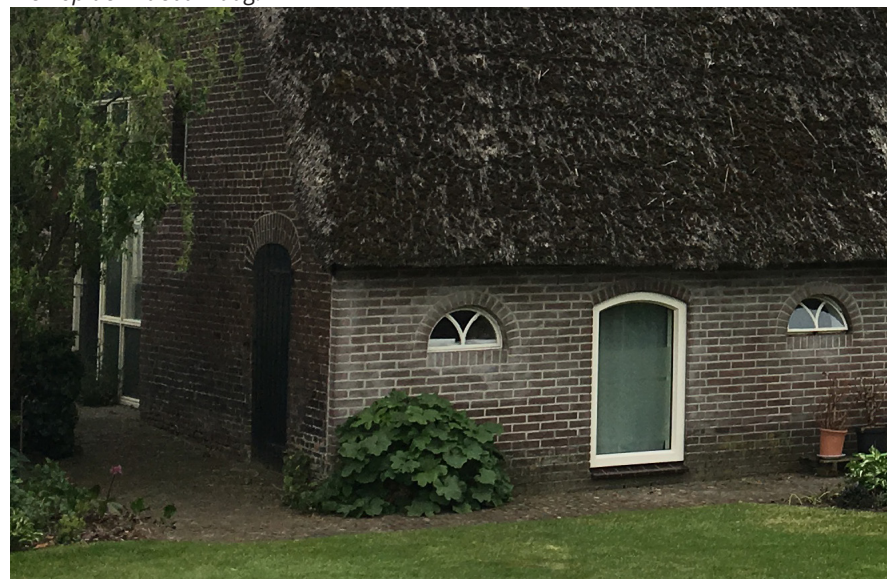
Afb. 11 Aansluiting op achtergevel middels een staande voeg.
