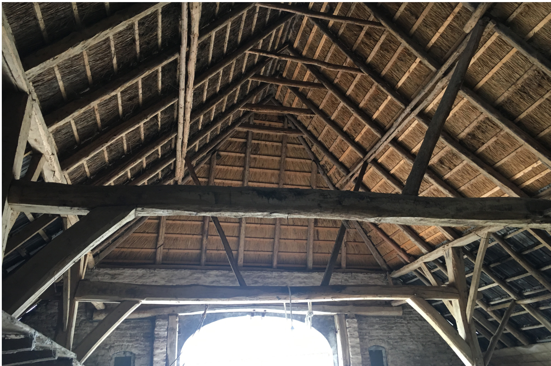
Afb. 16 De doorijschuur heeft een gave, open structuur. De slieten zijn verdwenen.
